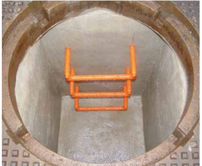
Mit KÖSTER Schachtmörtel sanierter Schacht
